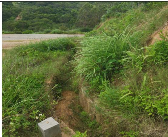
13 号机位安装平台边坡植被恢复及坡脚排水沟
